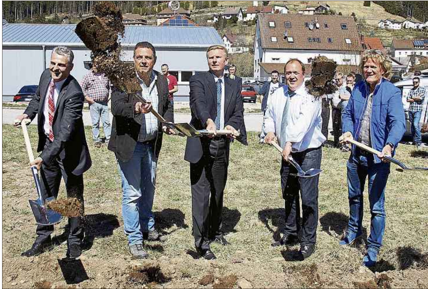
Erster Spatenstich für den Neubau in Vöhrenbach (von links): Peter Heine von der Sparkasse, Bauleiter Stefan Weißer, der Vöhrenbacher Bürgermeister Robert Strumberger, Firmenchef Pascal Fink und Architekt Joachim Müller. Fotos: Heimpel
